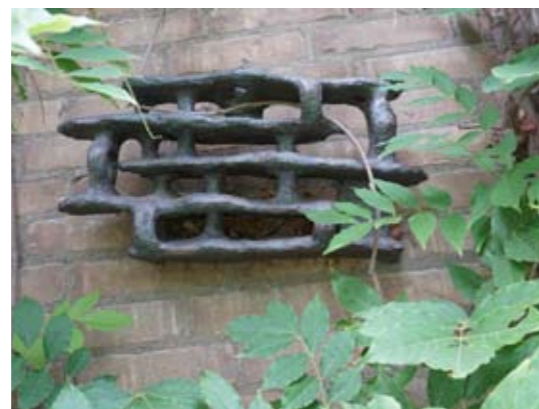
Gevelobjecten Jan van Stolk aan de oostgevel.
